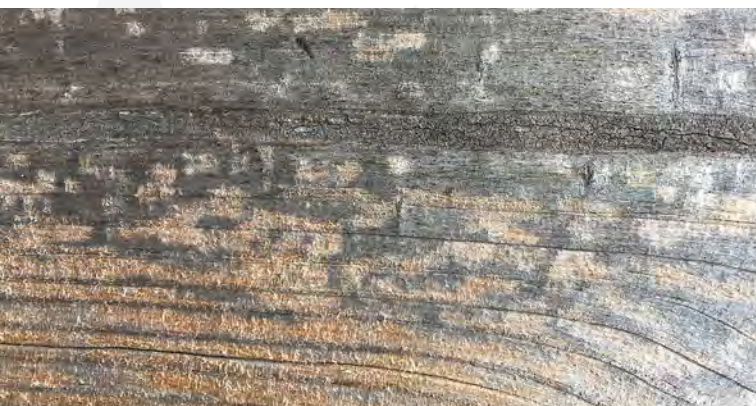
Fasádny obklad v priebehu procesu starnutia (nepravidelné uvoľňovanie – vymývanie drevného vlákna)
