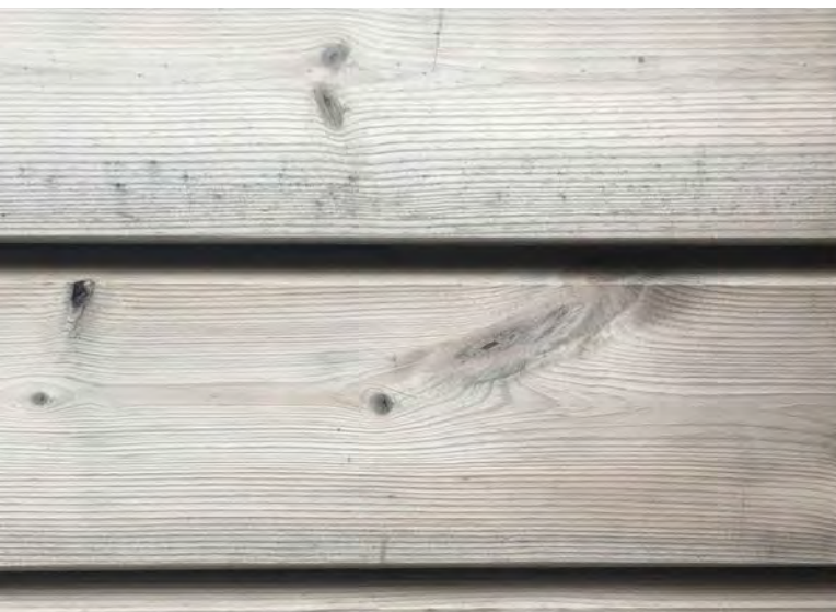
Detail na ideálne ventilovaný obklad (SSS) v priebehu procesu starnutia severná strana - vek 3 roky (krásna svetlo šedá farba - ľahké zvrásnenie povrchu)
